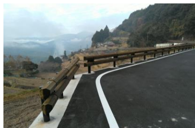
【三重県】木製ガードレール設置 (主)熊野矢ノ川線:熊野市内
