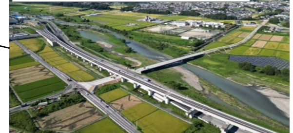
主要地方道 伊勢南島線 道路改良事業 (度会町)
