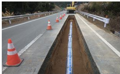
送水管布設替工事の施工例
