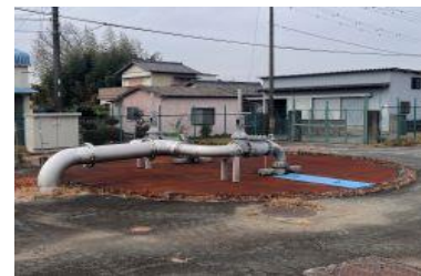
改良予定の施設 （新屋敷取水所取水井）
