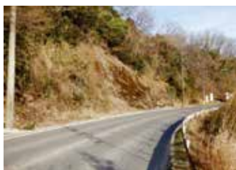
⑬ 国道 163 号 (伊賀市)
