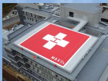
病院屋上ヘリポート
